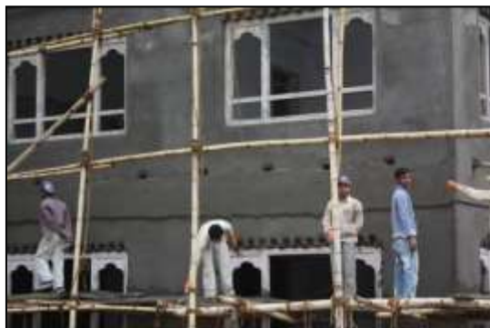
写真 7 建設現場で働くインド人労働者(パロ)
